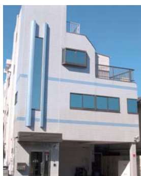
(株)測範社 本社・工場外観
